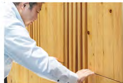
工場でブロックごとのパネルにして、現場に持ち込み、細部を調整してネジで止めている。節も何箇所と埋木をしています、誰にも知られていませんが。
